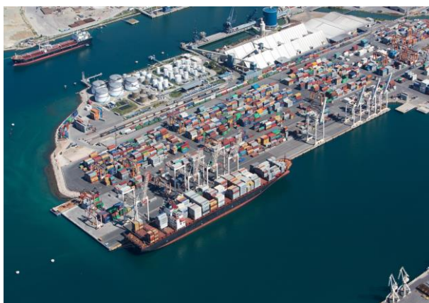
Nadgradnja kontejnerskega terminala na pomolu I
