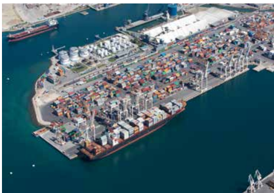
Nadgradnja kontejnerskega terminala na pomolu I
