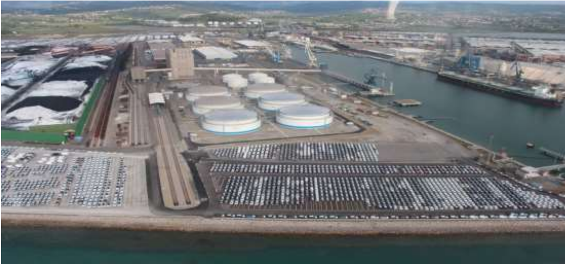
Severni del kasete na čelu Pomola II
