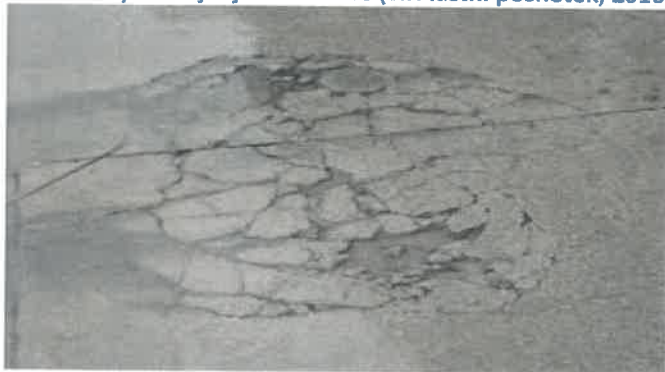
Slika 92: Vpliv soljenja na vozišče (vir: lastni posnetek, 2010)
