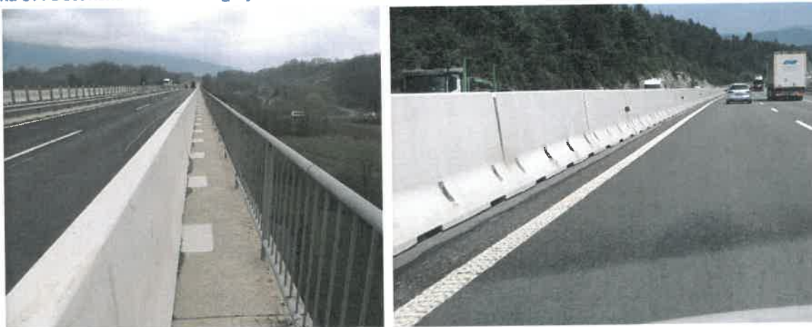
Slika 37: Betonska varnostna ograja
