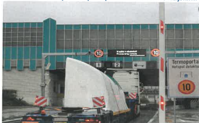
Slika 44: Skeniranje vozil pred predorom s termovizijskimi kamerami
