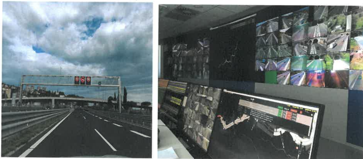
Slika 39: Spremenljiva signalizacija in Regionalni nadzorni center Kozina
