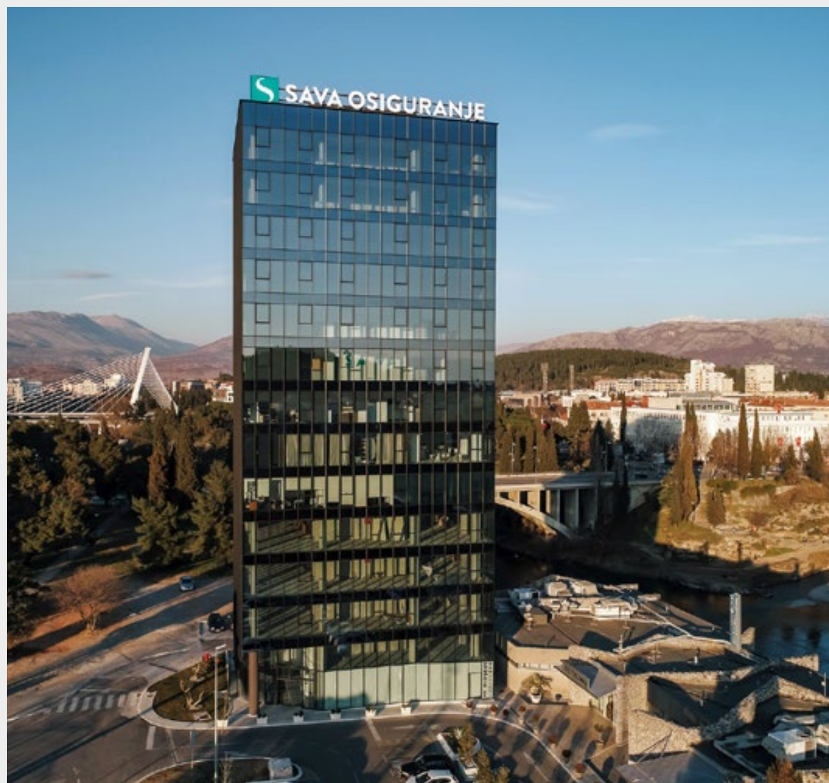
Novi poslovni prostori v Črni gori imajo sodoben in energetsko učinkovit sistem ogrevanja in hlajenja.
