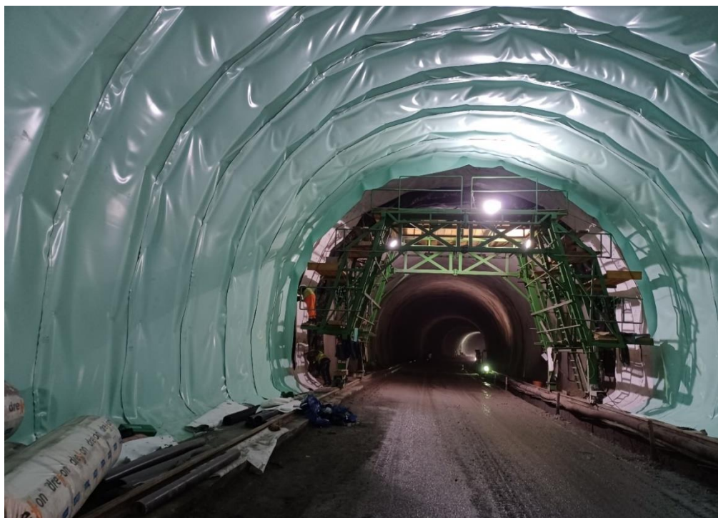
Slika 7: Montaža sloja hidroizolacije v predoru
