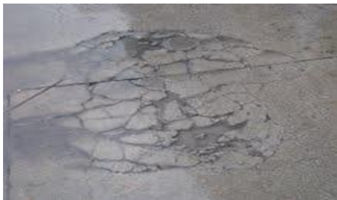
Slika 90: Vpliv soljenja na vozišče (vir: lastni posnetek, 2010) Slika 91: Tipi raztopin pri mokrem posipanju
