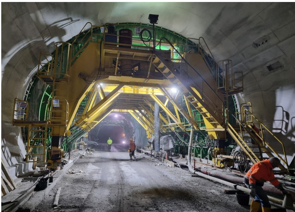
Slika 8: Betoniranje notranje betonske obloge v predoru
