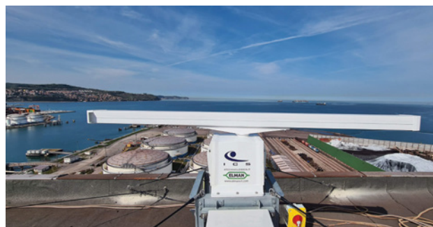
Radarski sistem za zaznavanje onesnaženj na morju, nameščen na strehi silosa v Luki Koper, d. d. Foto: Jure Barovič
