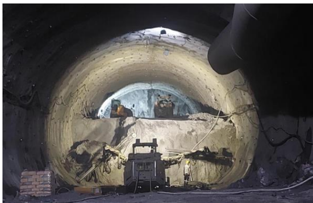
Slika 7: Vgradnja sider na stiku stopnica–talni obok
