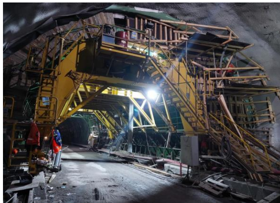
Slika 8: Betoniranje notranje betonske obloge v predoru
