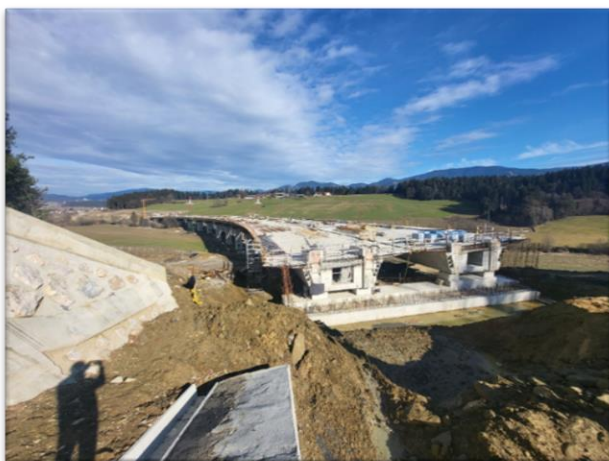
Slika 9: Pogled na gradbišče viadukta Jenina na sklopu F – Jenina
