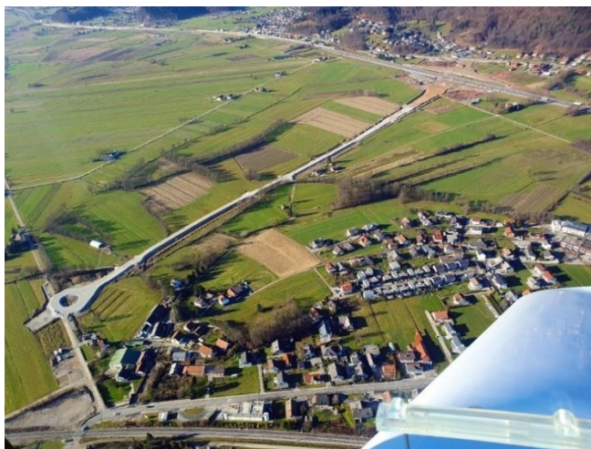
Slika 11: Gradbišče priključka Dragomer iz zraka
