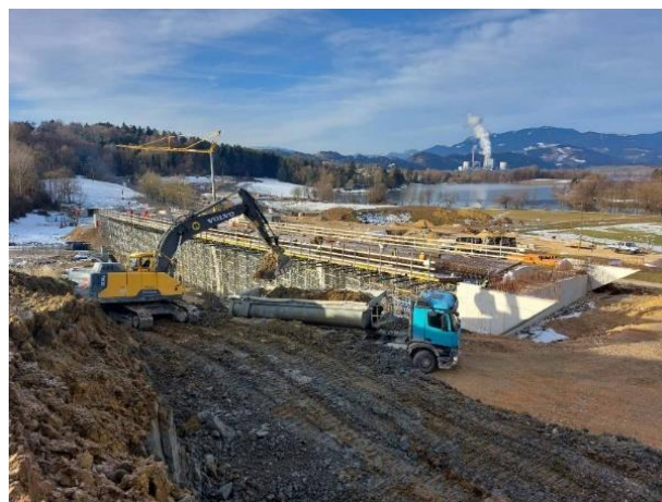
Slika 10: Pogled na gradbišče na sklopih B – Škalsko jezero in H – Konovo
