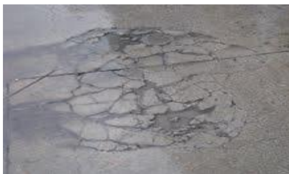
Slika 61: Vpliv soljenja na vozišče (vir: lastni posnetek)
