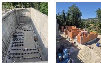
Slika 2: Izgradnja nove čistilne naprave
